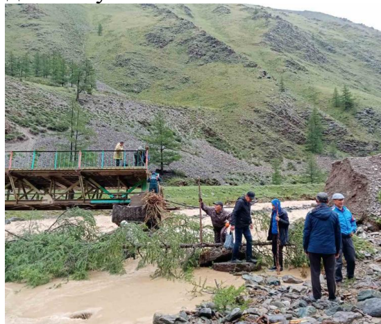
Рис. 3.15. Разрушение полотна дороги и моста через р. Барлык в Монгун-Тайгинском районе
