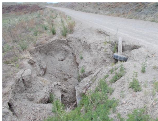
Рис. 3.13. Активизация эрозионных процессов на участках автодороги Чадан – Ийме в Дзун-Хемчикском районе с разрушением обочины и частично полотна дороги
