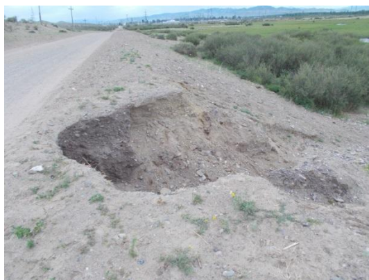
Рис. 3.13. Активизация эрозионных процессов на участках автодороги Чадан – Ийме в Дзун-Хемчикском районе с разрушением обочины и частично полотна дороги
